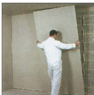
Lepljenje ploča - suvo malterisanje
