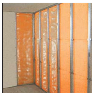
Termozolacija zida iznutra
